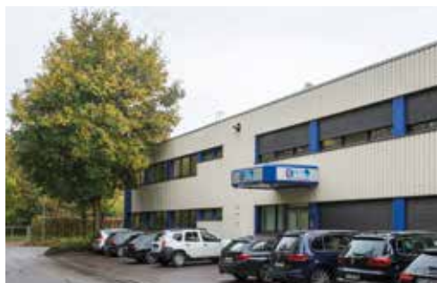
Firmengebäude in Nürtingen
